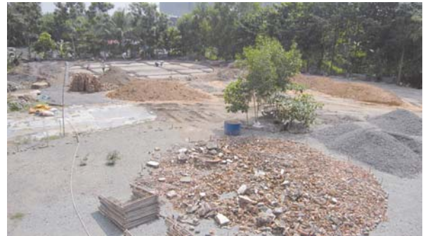
工事が進む寺院の庭園
