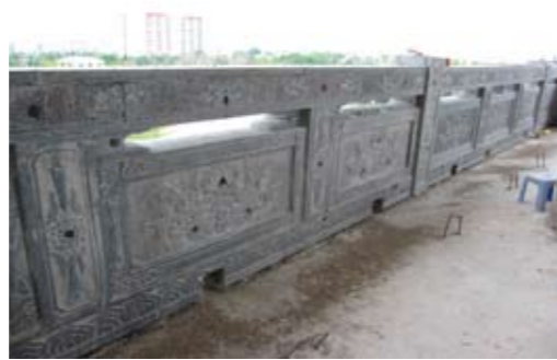
現地のスタッフとともに細部にわたった作業(左) 装飾は柵を直接削り出している(右)
